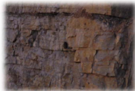
Mission d'expertise sur le Grand-duc en carrière de roche massive
