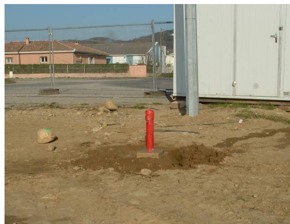
Pose de piézomètre
